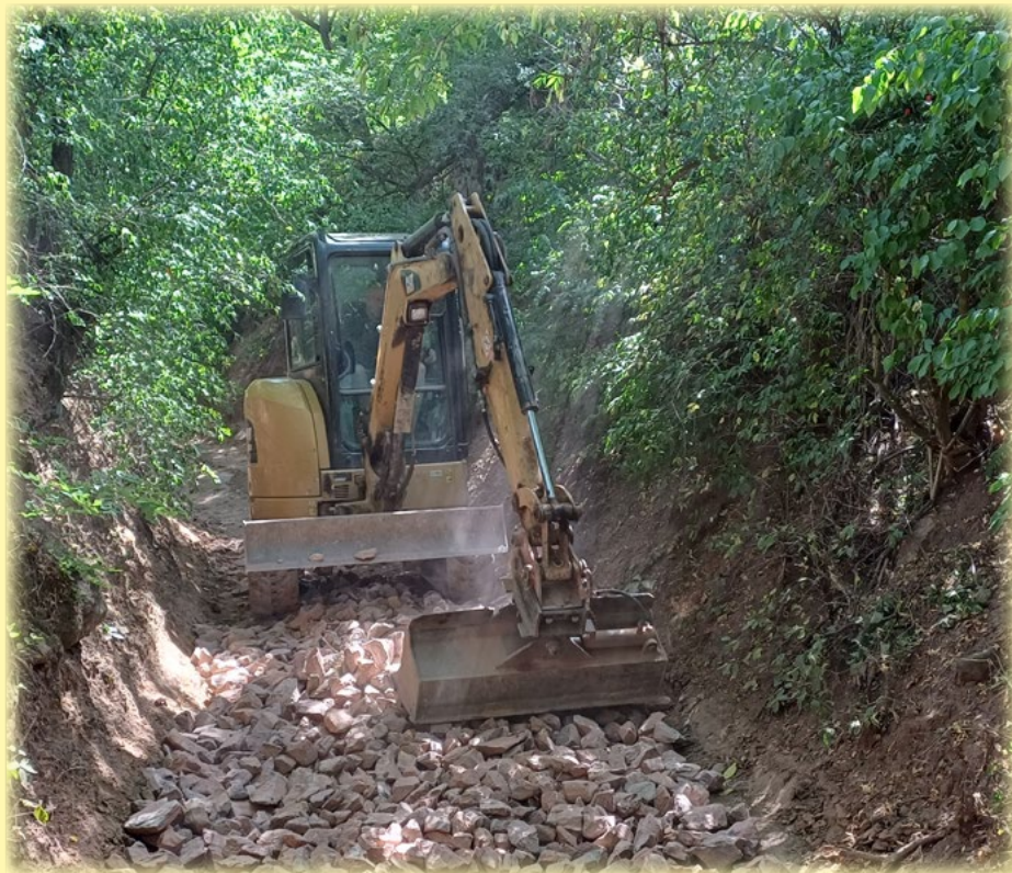
Oprava úvozové cesty na Pindulce
